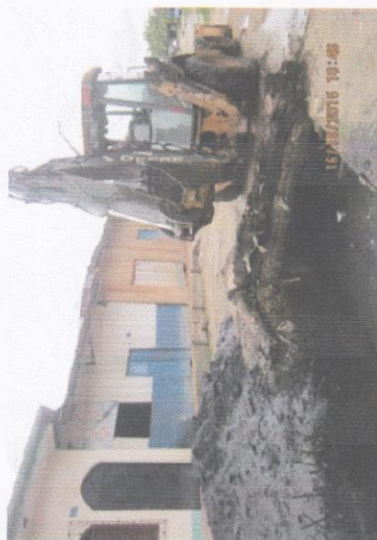
Trabajo de limpieza mecánica con uso de equipo de draga, bombeado a un volquete
