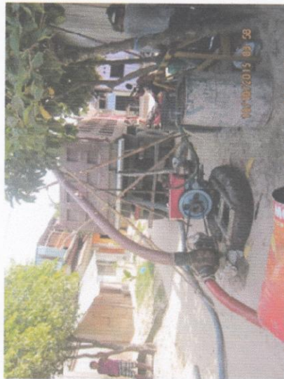
Trabajo de limpieza mecánica con uso de equipo de draga, bombeado a un volquete
